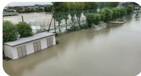
冠水した運動場
