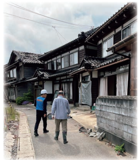
【現地調査の様子】
